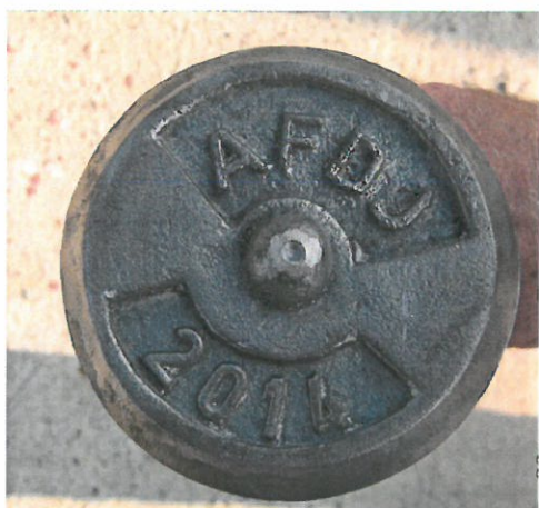
Figura 3 - Marcă de tip STAS cu inscripție AFDJ 2014
